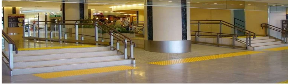
चित्र 5.12 चेतावनी पट्टी की एक पंक्ति वाली लैंडिंग/अवतरण
