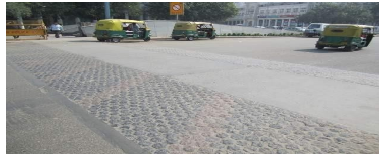
चित्र 5.3 ढलान पर कोबल स्टोन के साथ टेबलटॉप और शीर्ष पर सीमेंट कंक्रीट सतह
